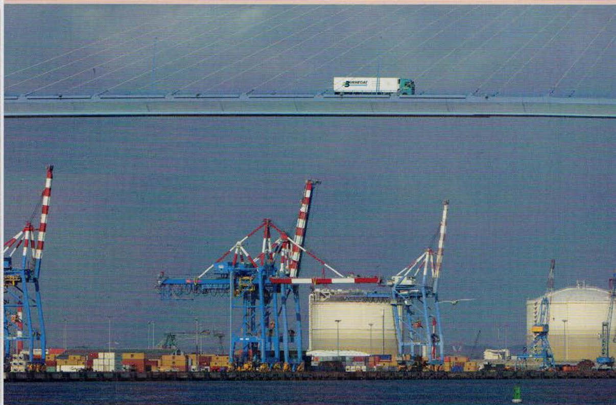
Pont de Saint-Nazaire au-dessus de l'estuaire de la Loire.
